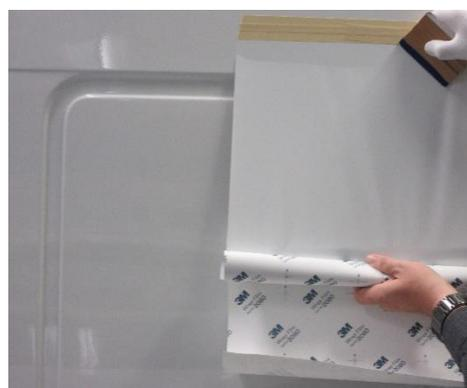
Die Folien benötigen einen hohen Rakeldruck, um Luftblaseneinschlüsse zu vermeiden. Deshalb wird der Einsatz des 3M™ Plastikrakel Gold (PA-1) mit dünnen, weichen Manschetten empfohlen. Benetzen der Rakelmanschette mit entspanntem Wasser hilft, Kratzer auf der Folienoberfläche zu vermeiden.
