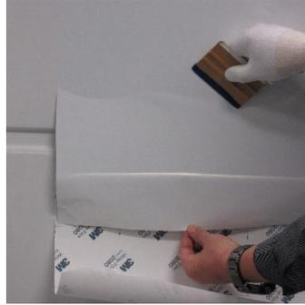
Die Folie wird mit dem Daumen oder mit einem Handroller (3M™ Roller S und L) in die Vertiefung verklebt. Bei manueller Verlegung sollten Textilhandschuhe getragen werden, um die Reibung zwischen Folie und Finger zu vermindern.
